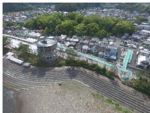
中土佐町第 1 号津波避難タワー
